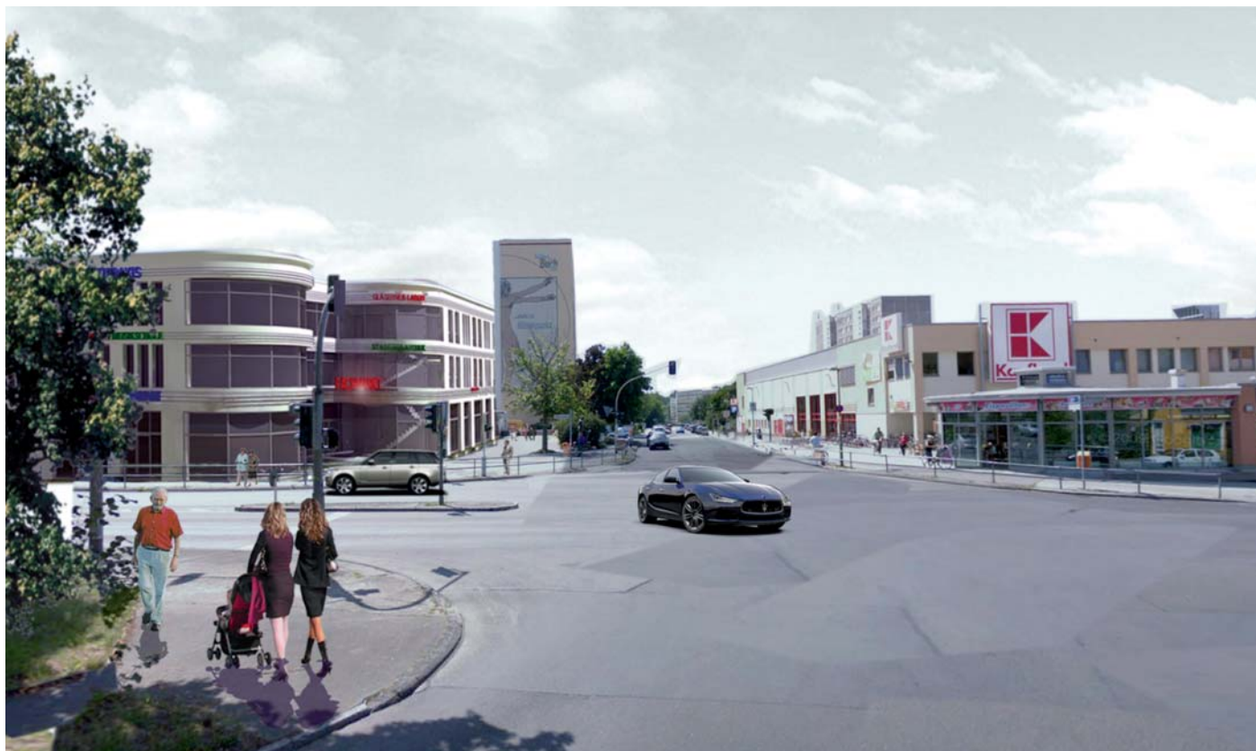
DAS NEUE GEBÄUDE BIETET PLATZ FÜR MUSIKSCHULE, VOLKSHOCHSCHULE, BIBLIOTHEK UND DAS GLÄSERNE LABOR
