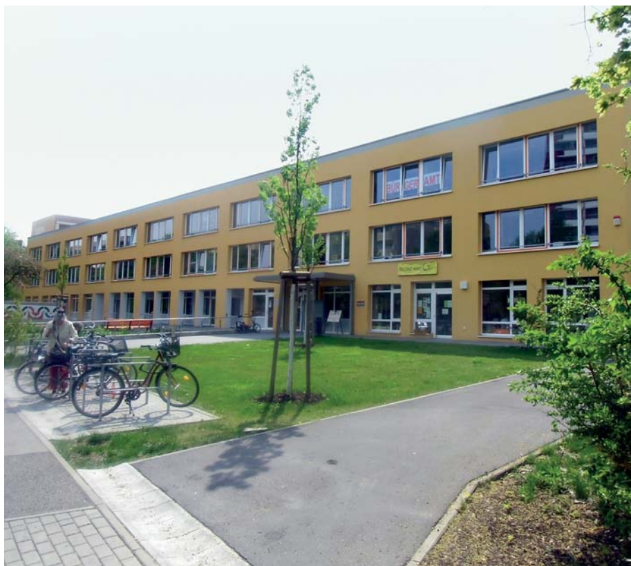
UMBAU EINES KINDERGARTENS: IN DAS NEUE „BUCHER BÜRGERHAUS“ ZOGEN IM FRÜHJAHR 2012 KOMMUNALE EINRICHTUNGEN WIE DAS BÜRGERAMT SOWIE BERATUNGS- UND BILDUNGSANGEBOTE FREIER TRÄGER UND DES BEZIRKS EIN.
